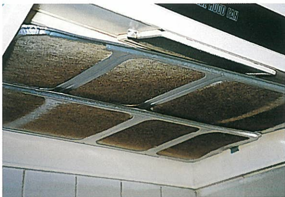
目詰まりして換気・排気能力が著しく低下した、市販の交換式フィルター
